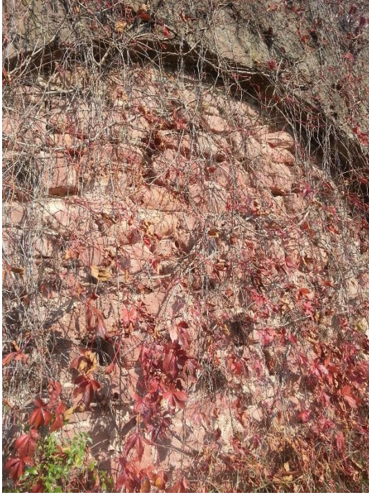
Abb. 6.1.3: Spaltenreiches Mauerwerk unter Bewuchs der Gewöhnlichen Jungfernrebe ( Parthenocissus inserta (KERN.) FRITSCH).
