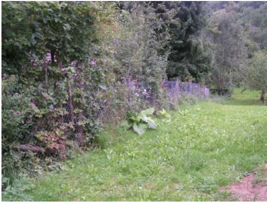
Abbildung 12: Östlich gelegener Bereich außerhalb des Grundstücks
