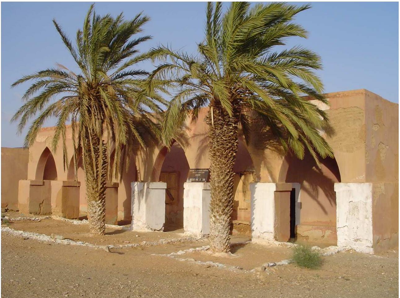
Bâtiment de l'ancienne Station de Recherches Présahariennes d'Aouinet Torkoz.
