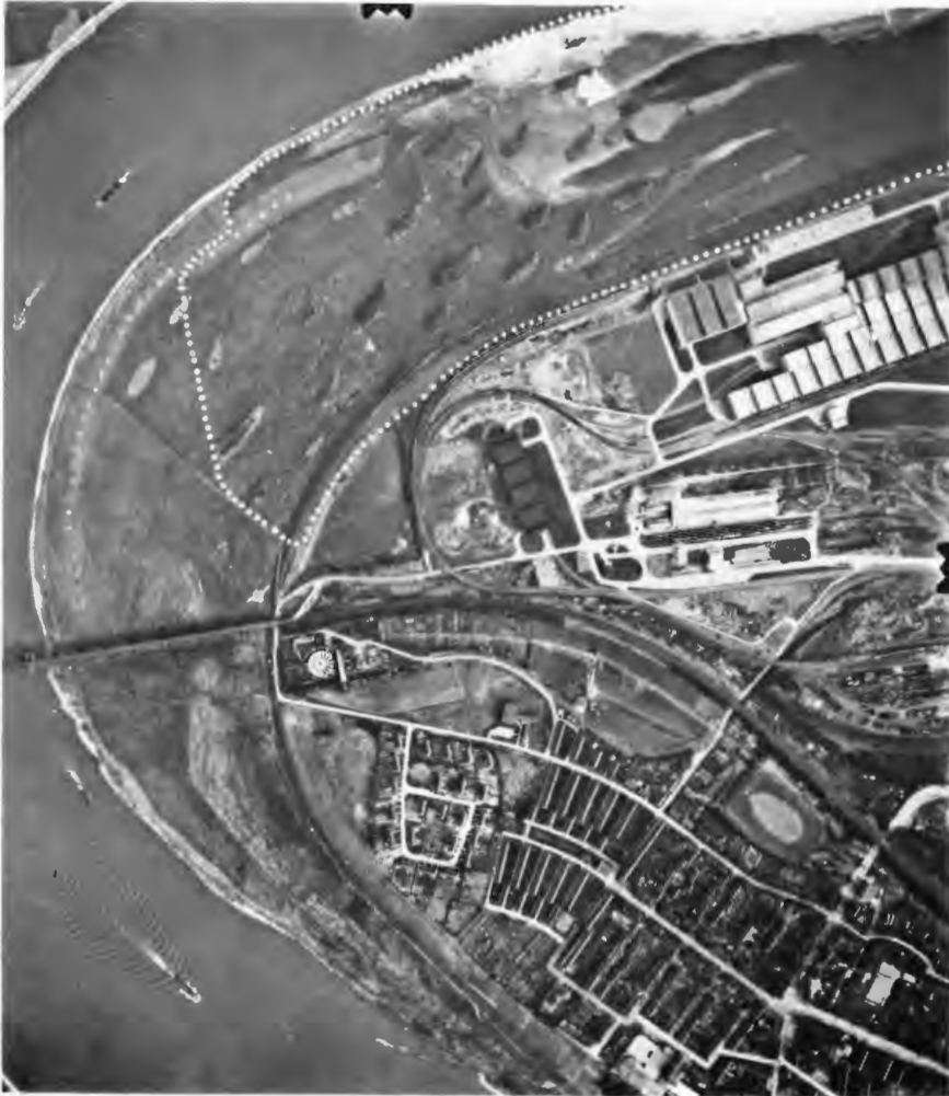
Abb. 48: Kniep-Alsumer Ward, Luftaufnahme vom 25. 3. 1968 (Veröffentlicht mit Genehmigung des Landesvermessungsamtes NW vom 17. 12. 1986, 751/86).
