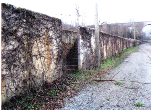
À Nolay, l'ancien mur de soutènement en pierre, de plus de 200 mètres de longueur, a été remplacé il y a environ 35 ans par ce mur en plaques de béton. Les cachettes que le Lézard des murailles peut y trouver sont nécessairement limitées, et il devra attendre qu'il se dégrade et se fissure pour à nouveau bénéficier d'un habitat favorable.
